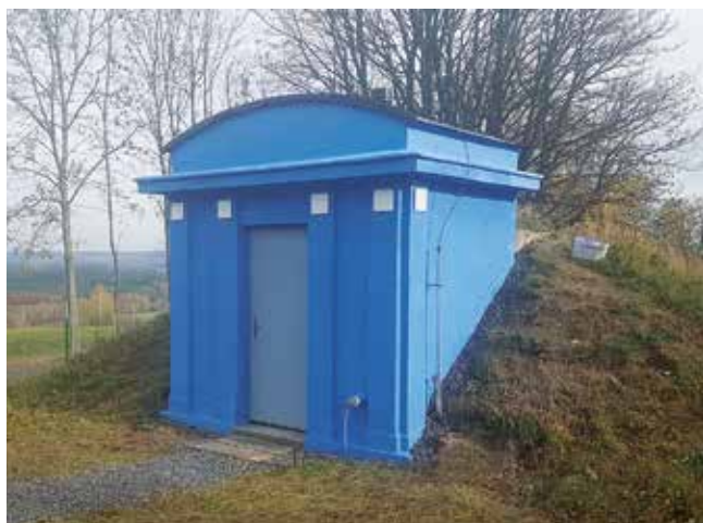
Vodojem Frýdlant-Údolí o objemu 50 m 3
