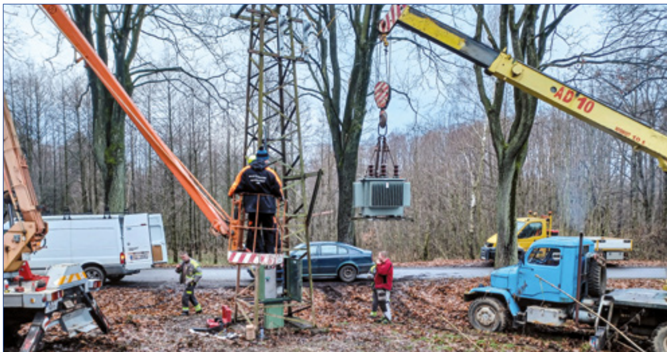
Instalace nového trafo
