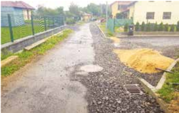
Frýdlant, ulice Spojovací – vodovod – 1,7 mil. Kč
