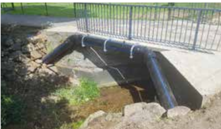
Bulovka – přechod vodovodu přes vodoteč – 0,4 mil. Kč
