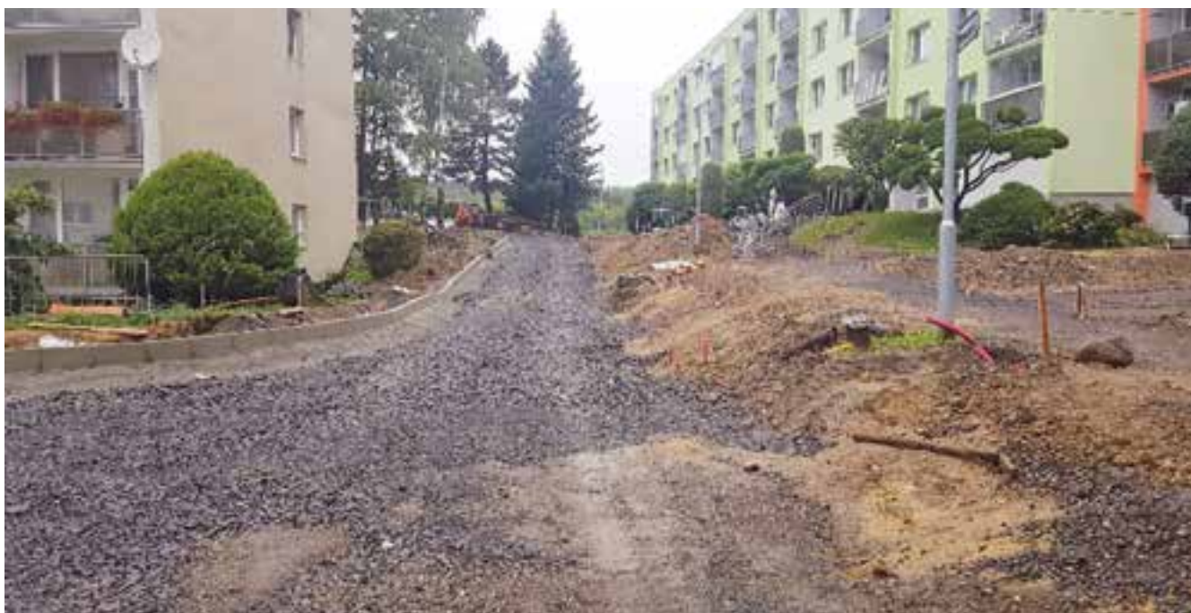
Frýdlant, ulice Kaplického a U nemocnice – vodovod a kanalizace – 5,1 mil. Kč
