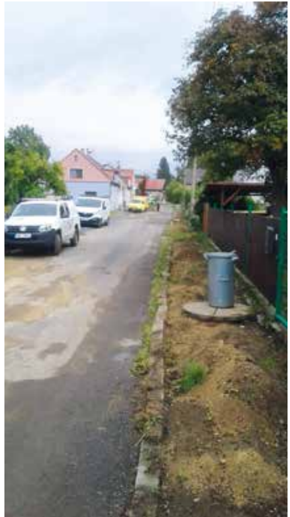
Nové Město pod Smrkem, ulice Boženy Němcové a U Hřiště – vodovod – 1,9 mil. Kč
