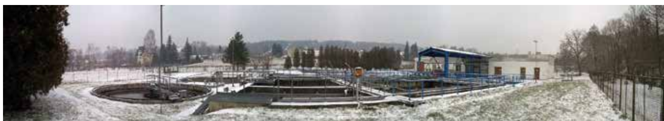
Čistírna odpadních vod Nové Město pod Smrkem
