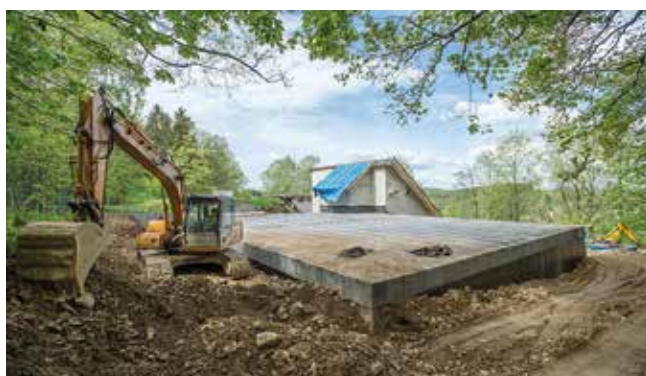
Časoběrné foto výstavby nového vodojemu Lázně Libverda
