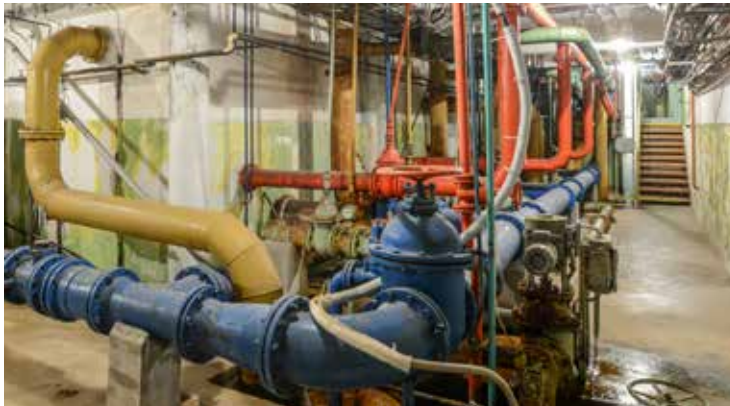
Stávající podzemní prostory úpravní vody – květen 2017.
